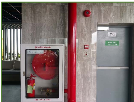
ภาพที่ 26 อุปกรณ์ระบบตรวจสอบและแจ้งเหตุเพลิงไหม้
