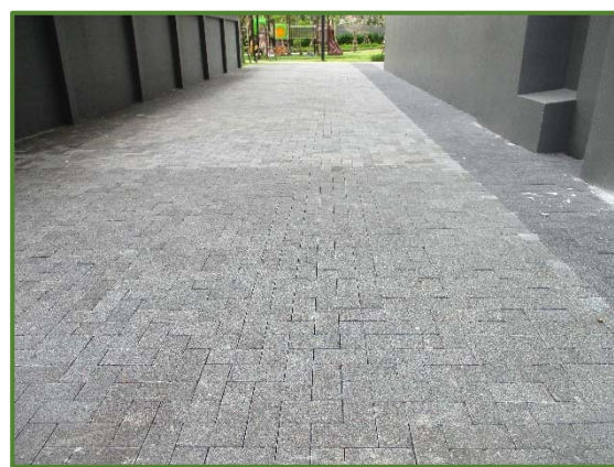
ภาพที่ 16 ถนนภายในโครงการปูด้วยบล็อกคอนกรีตพรุน (Porous Block Concrete)
