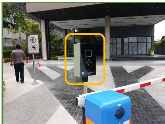
ภาพที่ 33 การใช้ระบบสัญญาณ Bluetooth แทนการแลกบัตรผ่าน
