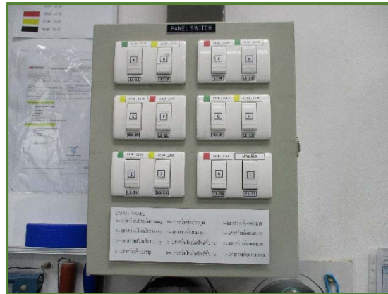
ภาพที่ 25 การแยกสวิตช์ควบคุมอุปกรณ์ไฟฟ้าแสงสว่าง
