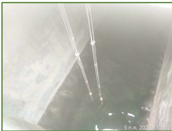
ภาพที่ 10 ถังเก็บน้ำใต้ดิน และถังเก็บน้ำชั้นดาดฟ้า เป็นถังคอนกรีตเสริมเหล็ก
