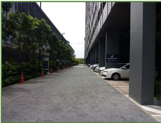
ภาพที่ 16 ถนนภายในโครงการปูด้วยบล็อกคอนกรีตพรุน (Porous Block Concrete)
