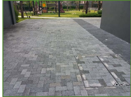
ภาพที่ 15 บ่อหน่วงน้ำเพื่อชะลอการไหลของน้ำส่วนเกิน
