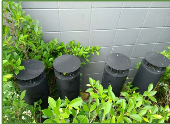
ภาพที่ 57 ระบบบำบัด Aerosol ด้วยวิธีผ่านกรอง (Filter)
