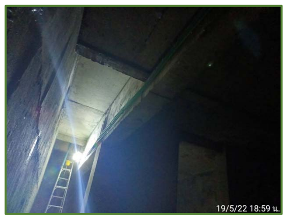
ภาพที่ 10 ถังเก็บน้ำใต้ดิน และถังเก็บน้ำชั้นดาดฟ้า เป็นถังคอนกรีตเสริมเหล็ก
