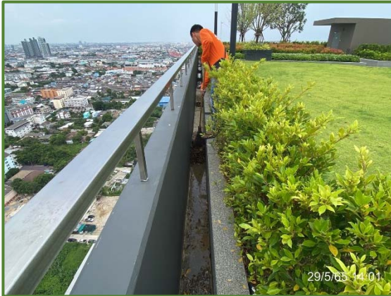
ภาพที่ 14 เจ้าหน้าที่ตรวจสอบท่อระบายน้ำ ดำเนินการขุดลอกดินตะกอนที่ตกค้าง
