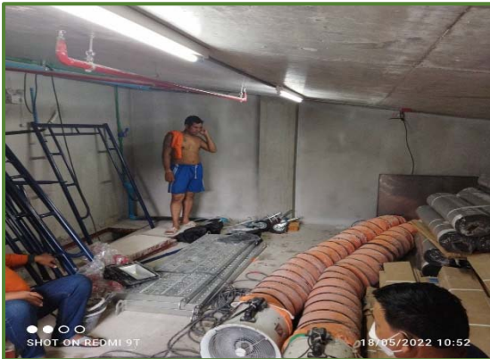
ภาพที่ 12 การล้างถังสำรองน้ำใช้ของโครงการ
